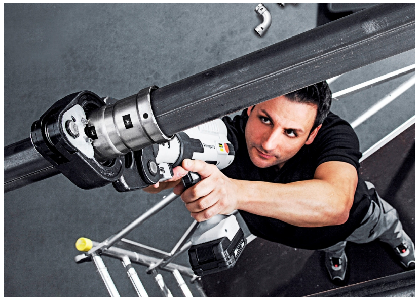
Mit Megapress steht die schnelle und sichere Pressverbindungstechnik von Viega jetzt auch für Installationen aus dickwandigem Stahlrohr zur Verfügung.
